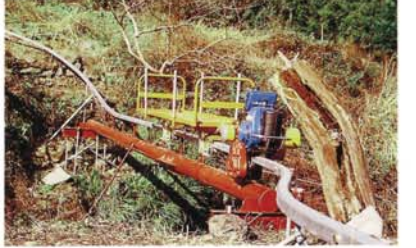
工法…橋梁渡し
