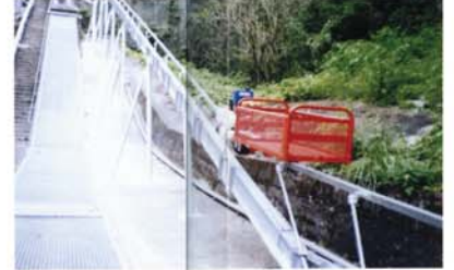
用途…発電所内、管理資材の運搬
